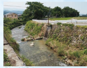
現在の大井取水口
