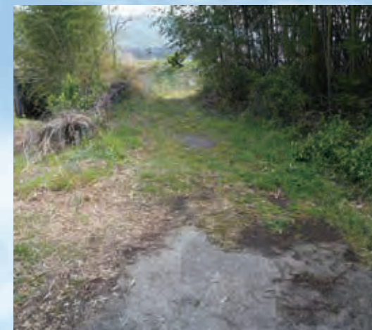
昭和38年3月竣工の山崎橋。竹藪が押し寄せているが、かつては車も通行できた。道の先は中央自動車道にぶつかる。
