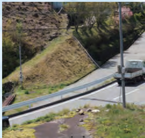
北から南を望む。中央線を通すため掘割で寸断された旧道の築堤部がよくわかる。
