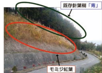
写真4 ハーモニック道路の斜面林(道路法面)の例
