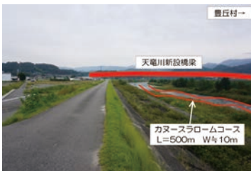
写真3 位置的イメージ写真(下流より)
