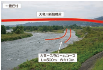
写真2 位置的イメージ写真(上流より)
