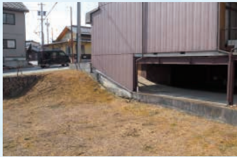
地階は倉庫に。道路の側面は石積み構造
