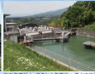
南向発電所上。ここから発電所へ導水される
