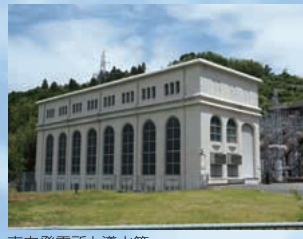
南向発電所と導水管
