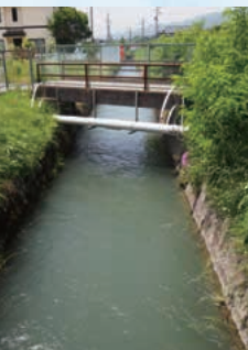
宮ヶ瀬橋北の開渠部
