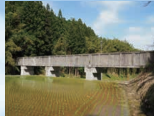
胡麻目沢水路橋
