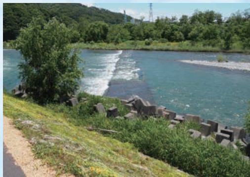
天竜川伏越。水面から見える
