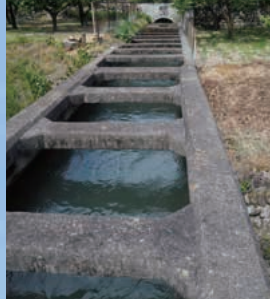
田沢川水路橋
