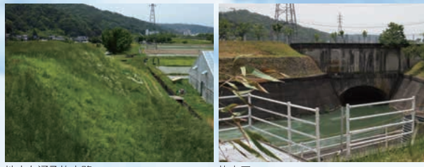
地中を通る放水路
