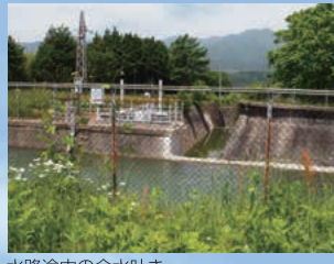
水路途中の余水吐き
