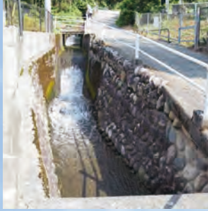
唐沢川と一貫水路の交差
