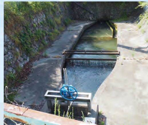
下市田第7号分水工
