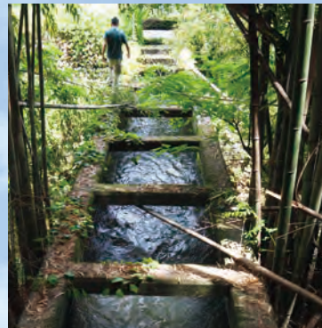
土曾川水路橋
