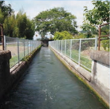
10号分水工手前の流れ
