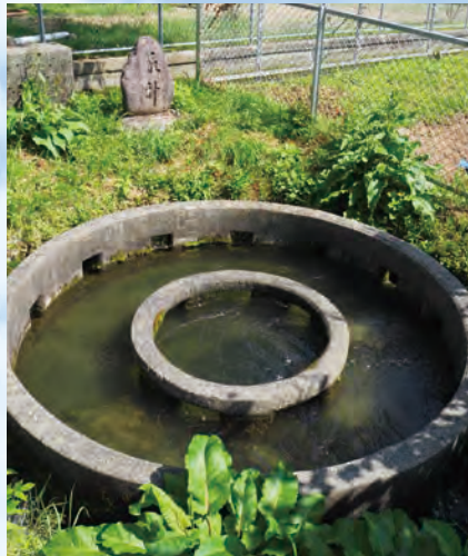
第10号分水工(円形分水工)
