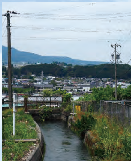
松川伏越・吐き口(飯田市松尾常盤台)
