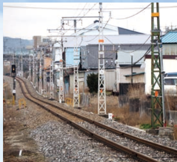
白い架線柱は新たに塗装されたもの(下平駅～市田駅間)
