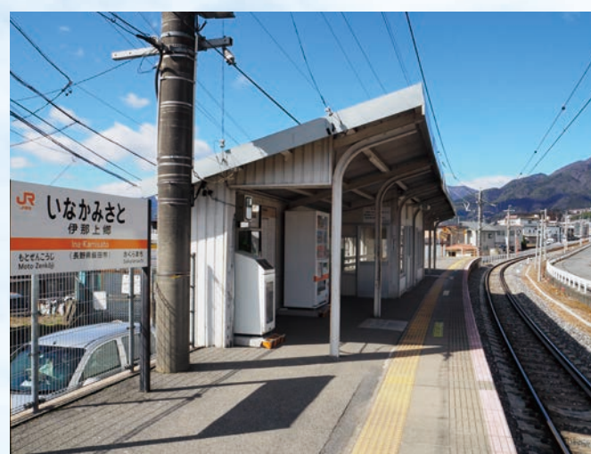
7本の廃レールが梁を支えている
