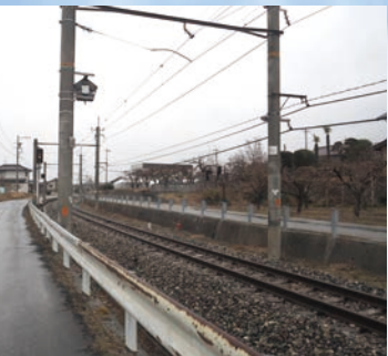
負荷のかかるカブなどにはコンクリート架線柱が並ぶ(市田駅～下市田駅間)
