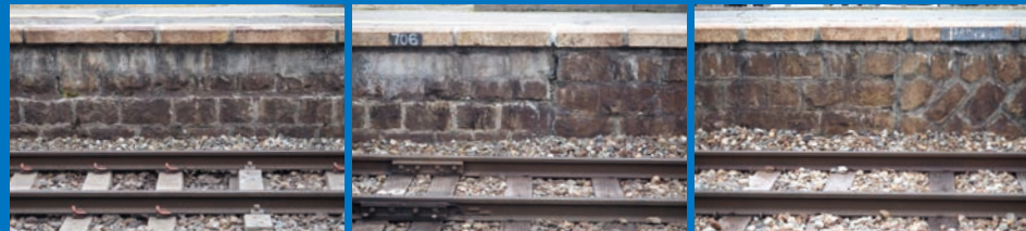
写真A. 上りプラットフォーム・辰野側の石積み 写真B. 同中ほどの石積み。布積みに変わっている 写真C. 豊橋側の石積み。布積みから谷積みに変わっている
