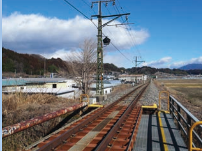
伊那電開通時からの、緑色の架線柱(下平駅～市田駅間)
