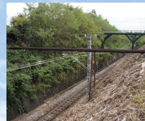
水管橋(手前)と跨線橋
