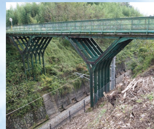
廃レールを使ったラーメン構造の跨線橋
